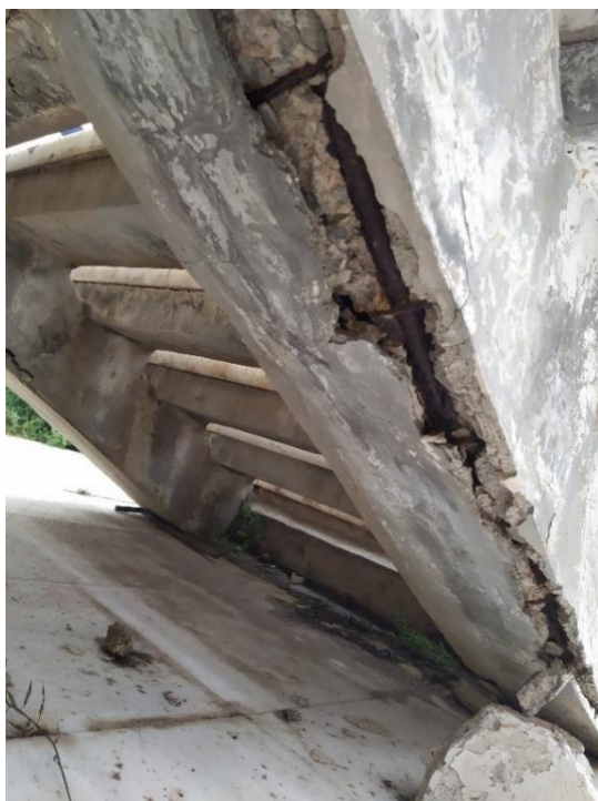
Φωτογραφία 1: Διάβρωση οπλισμού βαθμιδοφόρου.
